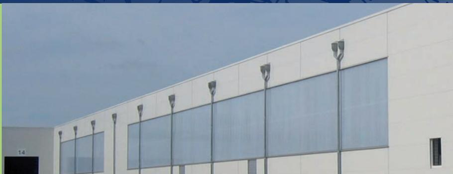
Metfiber Eco Wall Sound est un panneau sandwich métallique autoportant avec une isolation en laine de verre. C'est LA solution incontournable pour les locaux où des hautes valeurs d'isolation et d'absorption acoustiques sont exigées.
